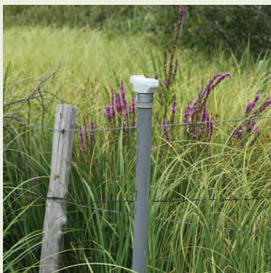
Piézomètre équipé d'une sonde de mesure automatique
