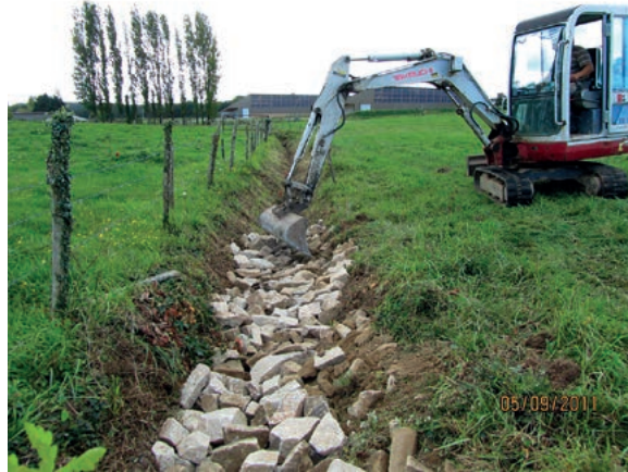
Rehaussement du lit du cours d'eau : positionnement de l'armature avec des blocs de granit à l'aide d'une mini-pelle, en septembre 2011
