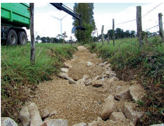
Habillage des pierres par du granulat fin, chargé depuis un camion benne équipé d'un bras articulé, en septembre 2011.
