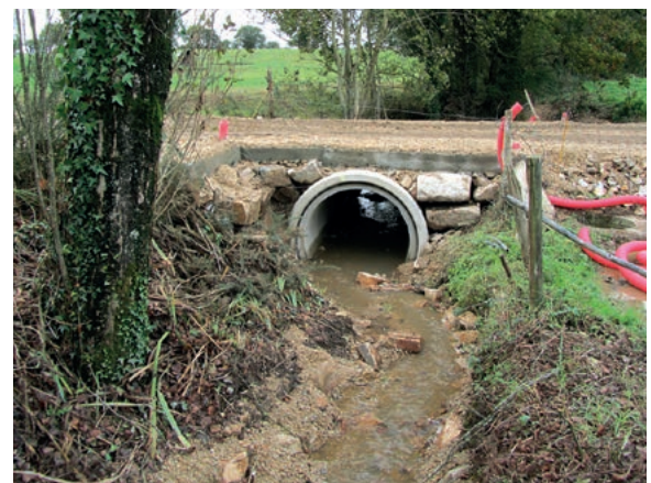
Remplacement de buse.
