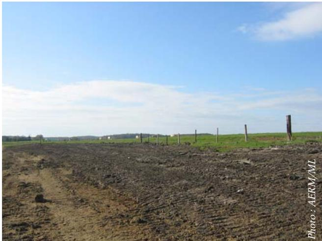
*Berges remodelées en pente douce pour limiter les effets du batillage, et mises en défens par la pose de clôtures.*
