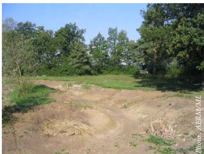
Frayère aux berges en pentes douces (juste après travaux)
