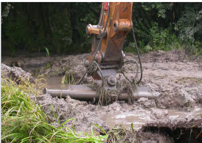
Extraction du drain
