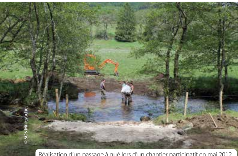
Réalisation d'un passage à gué lors d'un chantier participatif en mai 2012.
