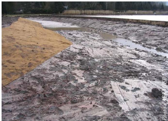
*Berges de l'étang du Marais après travaux : retalutage en pente douce, protection contre le battillage par un tunage en bois*
