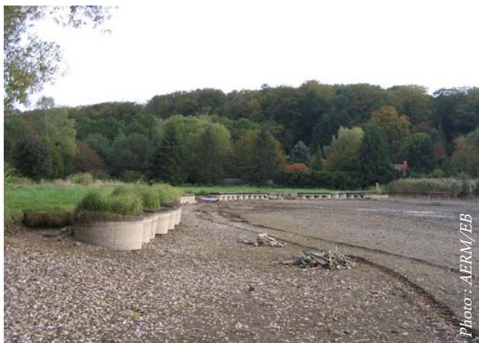
*Berges de l'étang du Marais avant travaux : protection contre le battillage par un tunage en béton*
