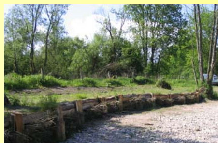
Après travaux : tunage en bois accompagné d'un lit de branches
