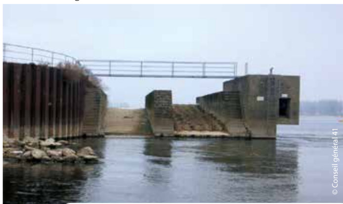
Le barrage, vannes baissées, avant son démantèlement : le môle en rive gauche sera lui aussi entièrement détruit.
