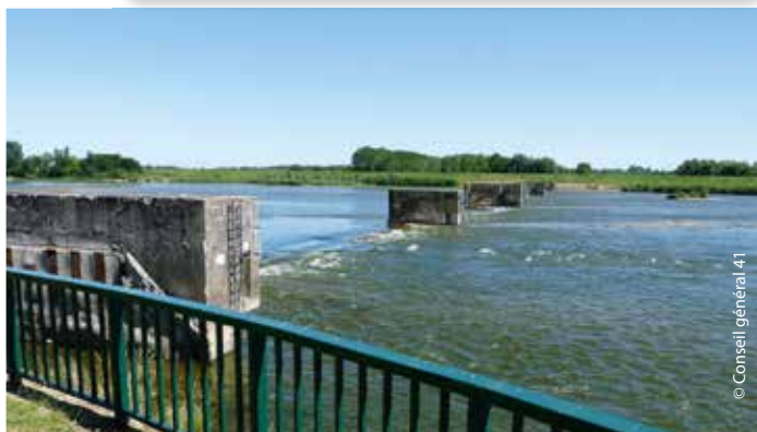
Le barrage après sa démolition : seules les piles subsistent.
