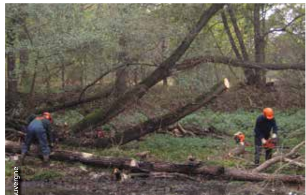
L'enlèvement d'encombres fait partie de l'entretien courant pour préserver la mobilité des cours d'eau. Ici dans un bras mort du secteur de Précaillé.
