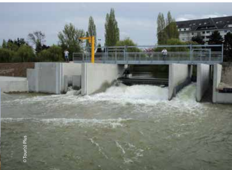
L'ouvrage de prise d'eau avec les passes à poissons, vu depuis le bassin de départ.
