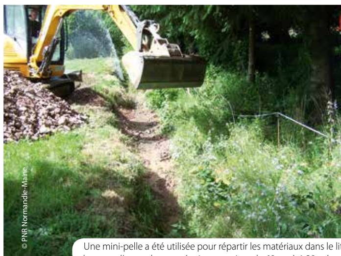
Aperçu de la recharge sur la portion aval. Le fond a retrouvé une granulométrie favorable au frai des truites et l'érosion latérale a déjà repris.
