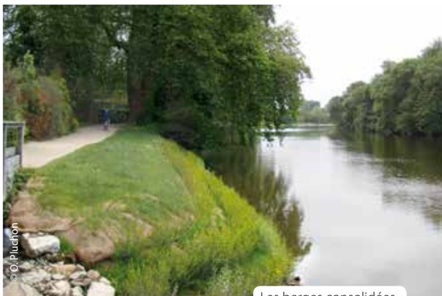
Les berges consolidées.
