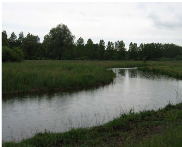
Reméandrage du fossé
