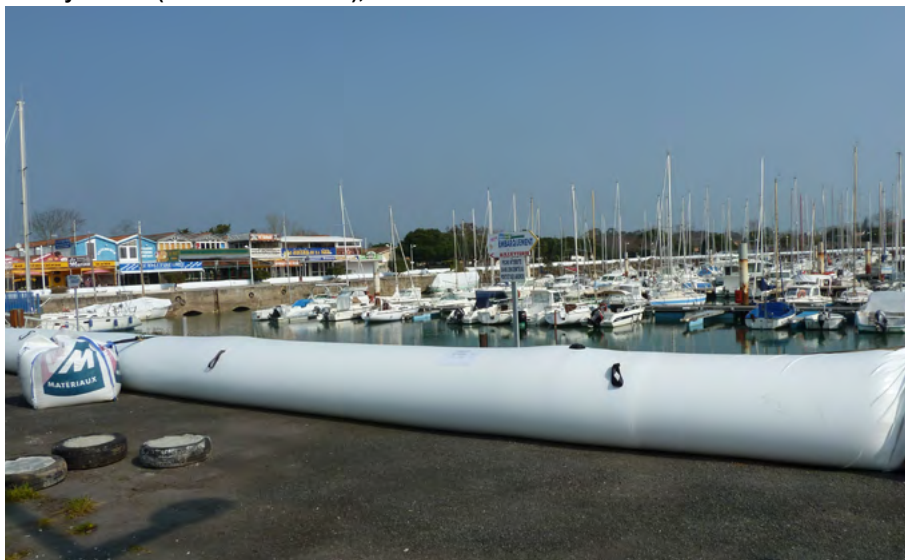
Photographie 17. Dispositif de protection du port et des habitations situées en contrebas de Boyardville (Charente-Maritime), contre les marées hautes de vive eau
