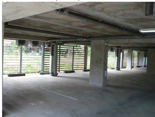
Photographie 16. Rez-de-chaussée "transparent" d'un bâtiment collectif à Saint-Paul (Réunion)
