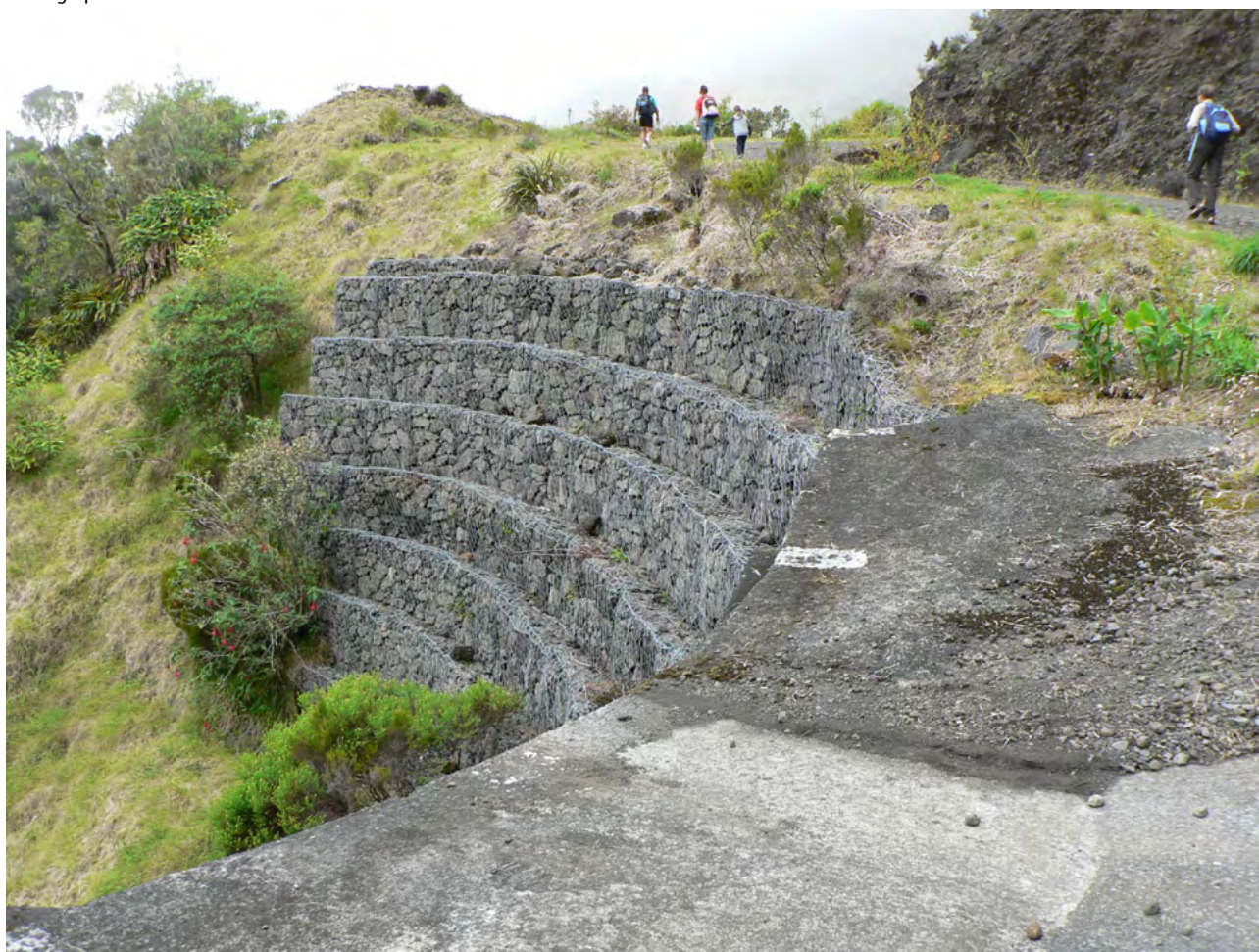
Photographie 12. Stabilisation de versant à la Réunion
