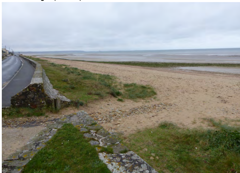
Photographie 11. Digue de protection contre les submersions marines à Saint-Vaast-la-Hougue (Manche)
