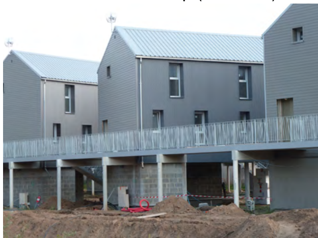
Photographie 15. Bâtiments en construction, adaptés aux inondations à Saint-Pierre-des-Corps (Indre-et-Loire)
