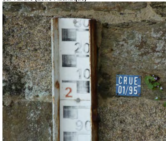
Photographie 4. Échelle limnimétrique et repère de crue sur l'Erdre (Loire-Atlantique)
