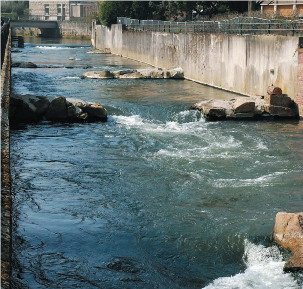
La Touques à Lisieux, en avril 2009, après l'arasement du barrage-clapet. Un parcours d'eaux vives fractionne le dénivelé du seuil résiduel.
