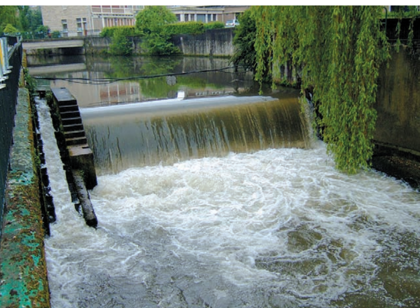
Le barrage-clapet de Lisieux avant son arasement. La passe à poissons en rive droite n'est pas fonctionnelle pour toutes les espèces migratrices.
