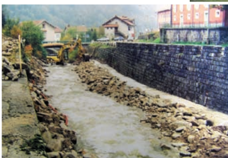
Effacement du barrage de l'usine sur le Ventron : la phase travaux en octobre 2003.
