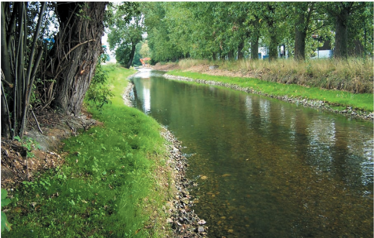
La Blaise en amont du seuil en 2008, après les travaux de restauration du lit mineur.
