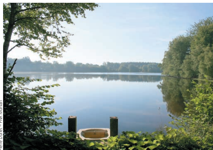
L'étang Fortier : installation d'un moine hydraulique.
