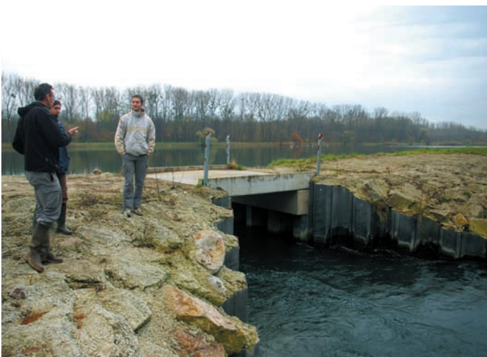
Redimensionnement de la prise d'eau sur le Rhin. Cet aménagement permet d'augmenter le débit entrant dans le massif alluvial (novembre 2008).
