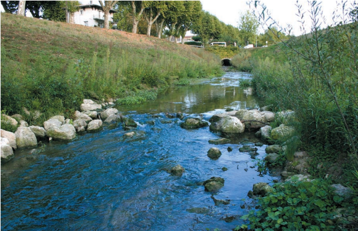
Le Trec en 2008, dix mois après les travaux de restauration. Diversification des écoulements par l'apport de matériaux.
