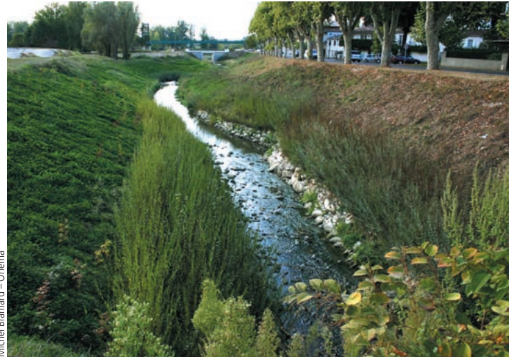
Le Trec en 2008, dix mois après les travaux de restauration. Diversification des écoulements et plantations d'hélophytes.
