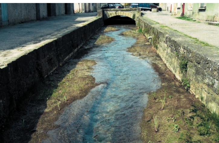
Le ruisseau de Montvaux après les travaux de restauration. Passage d'une crue sur les aménagements en décembre 1999.
