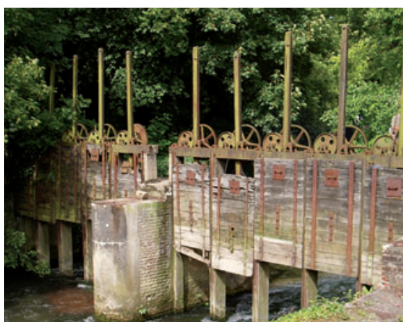
Ouvrage du Moulin de Sill avant démantèlement des vannes. Été 2009
