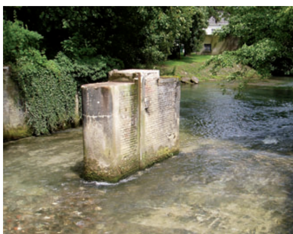
Ouvrage du Moulin de Sill après démantèlement des vannes. Juillet 2010
