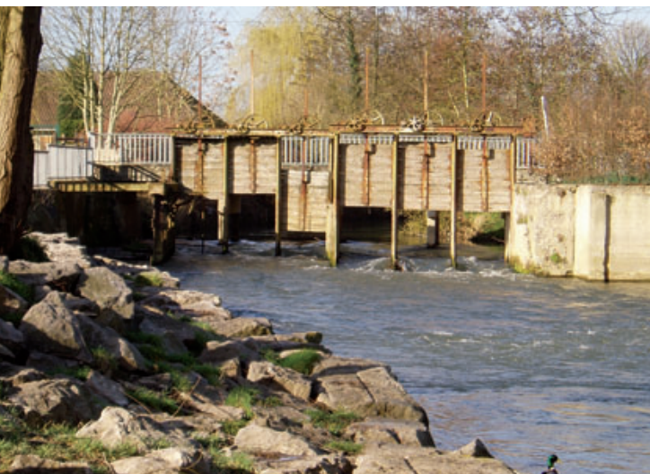
Ouvrage du moulin de Westhove avant démantèlement. Mars 2005
