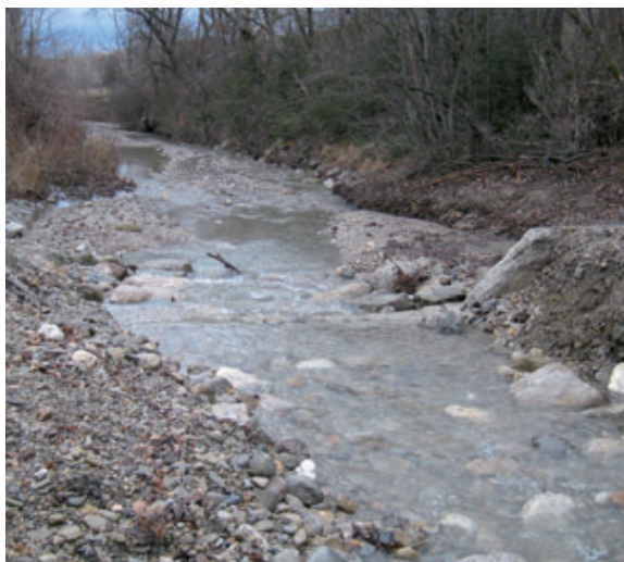
Le seuil du Vas après destruction partielle de l'ouvrage. Les fondations ont été conservées. Décembre 2007.
