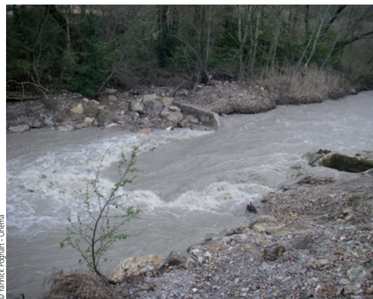
Le Seuil du Vas après effacement partiel de l'ouvrage et en période de hautes eaux. Mars 2008
