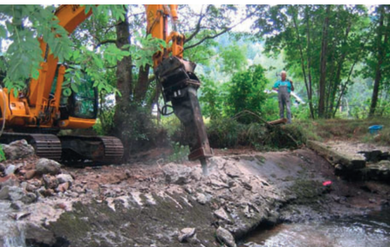
Piquetage du seuil avec un engin mécanique. Automne 2009
