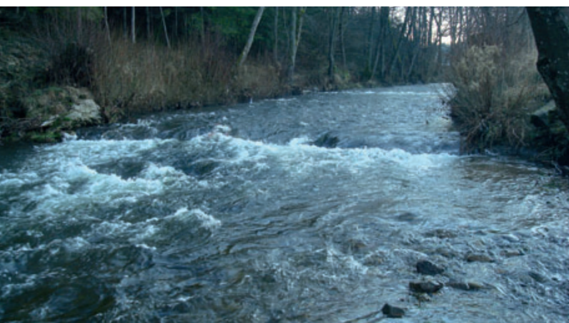
Vue amont de l'ancien seuil de Cros. Décembre 2011
