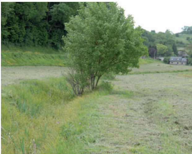
Le lit naturel du Fouillebroc, atterri et envahi par la végétation. Mai 2011
