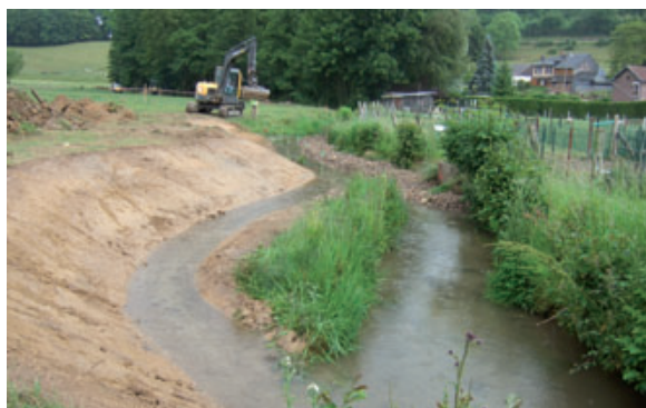
Retalutage des berges et reprofilage du lit naturel du Fouillebroc. Juin 2011
