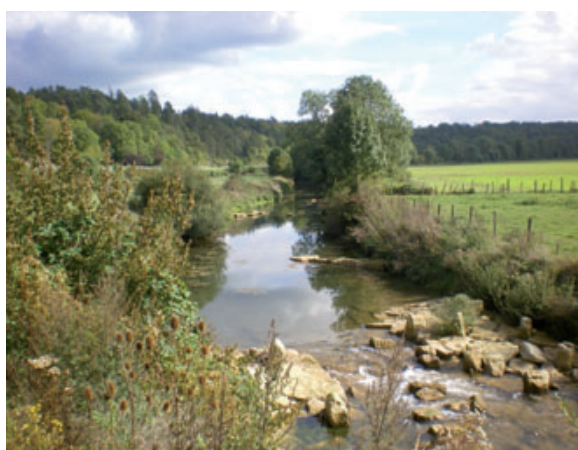
L'ancienne retenue de l'ouvrage et la rampe en enrochement visible au 1 er plan. Septembre 2010
