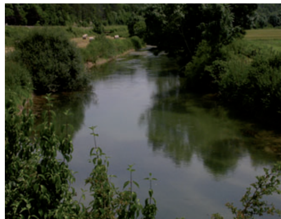
La retenue créée par l'ouvrage de la Granitière. Été 2008
