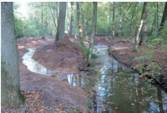
L'Hardtbach, pendant les travaux de création de méandres. Novembre 2010.
