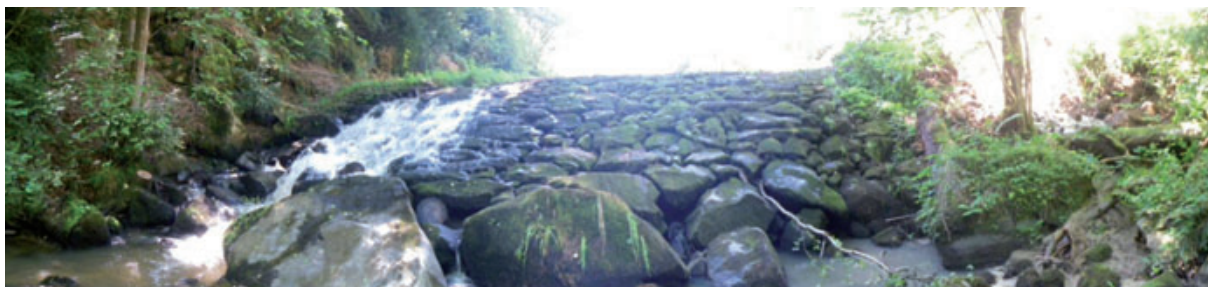
Le seuil de Chelles Basse avant les travaux d'effacement
