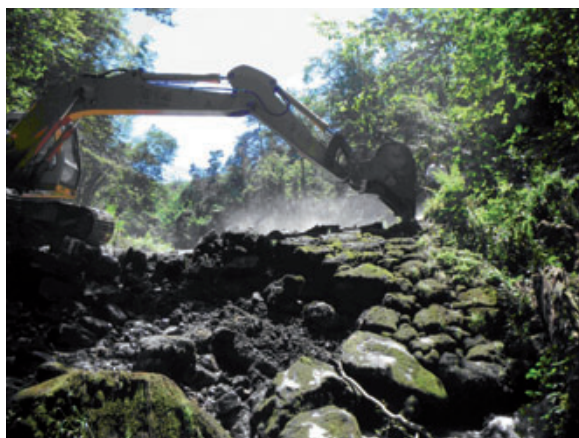
Destruction du seuil de Chelles Basse à la pelle mécanique. Juin 2010
