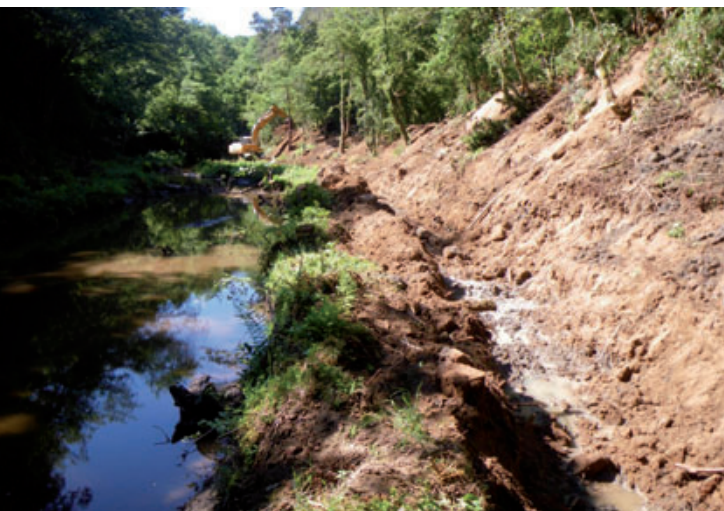
Mise en place d'un chenal de dérivation pendant les travaux.
