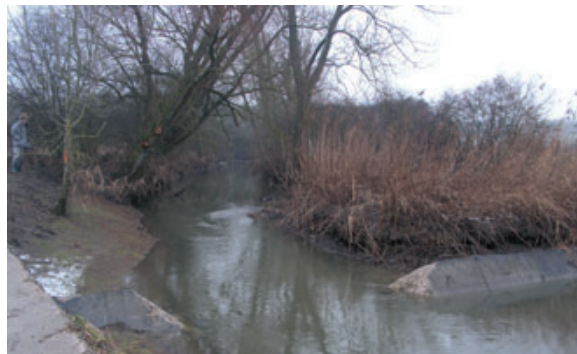
Seuil sur le Mutterbach, après réalisation des échancrures. Février 2010
