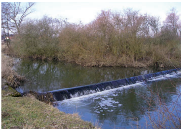
Surélargissement du cours d'eau au niveau d'un seuil sur le Mutterbach. Janvier 2009
