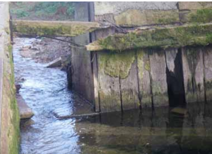
Le seuil de Guillen après réalisation de l'échancrure. Hiver 2010
