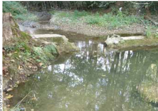
Le seuil de Piquet après réalisation de l'échancrure. Hiver 2010
