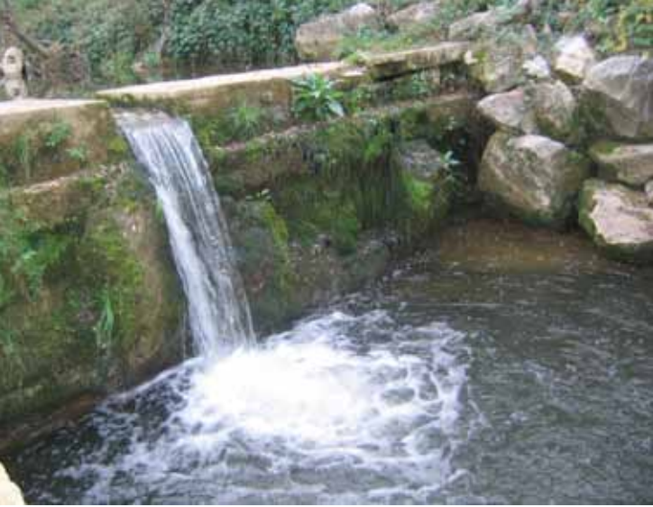
Le seuil de Guillen avant intervention. Octobre 2008
