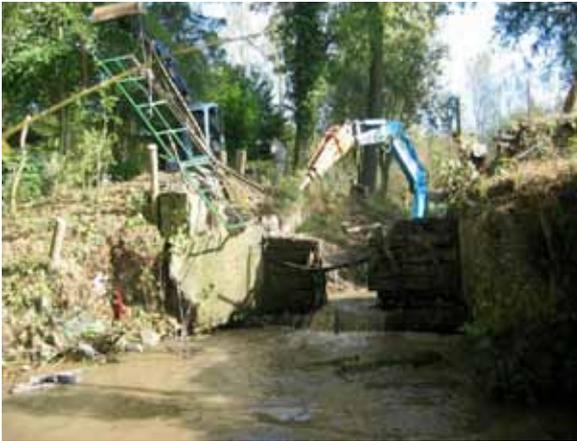
Dérasement du seuil à l'aide d'une piqueuse mécanique. Octobre 2009
