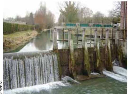
L'ouvrage du Pont Fourneau sur la Selle. Mars 2005
