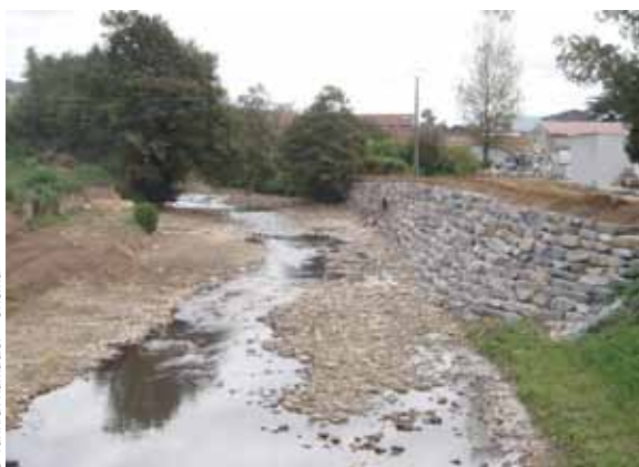
Vue du site après effacement de l'ouvrage. Octobre 2011
