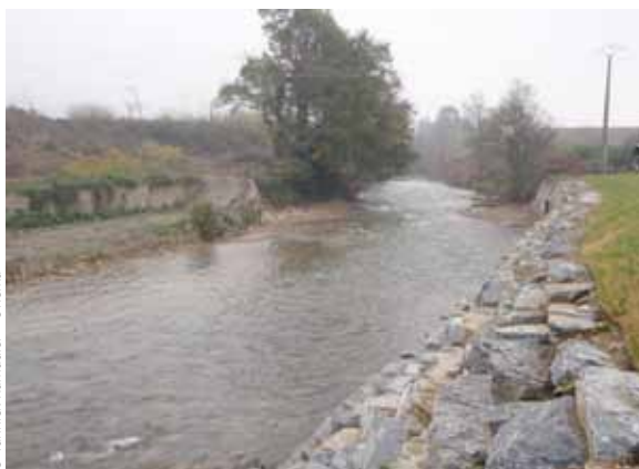
Vue de l'ancien seuil de Carayon après les travaux d'effacement. Décembre 2011
