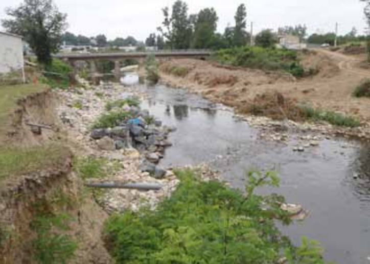
Vue aval du seuil de Carayon au tout début des travaux de restauration. Juillet 2011
