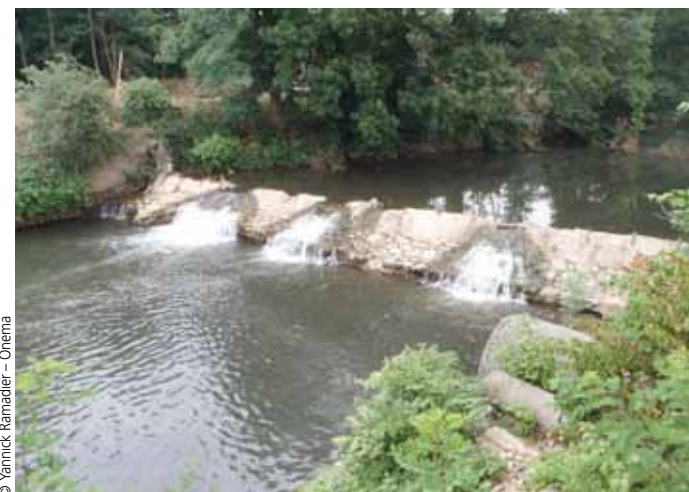
Vue aval du seuil de Carayon, avant effacement, ponctué par plusieurs brèches sur le déversoir. Juillet 2011
