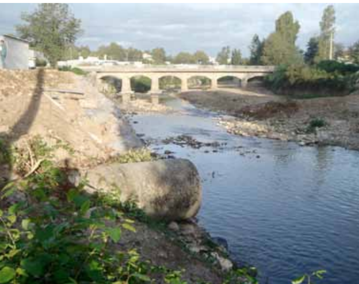
Les piles du pont en aval du seuil ont été dégagées afin de faciliter le passage des crues. Septembre 2011
