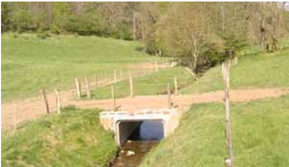
Six mois après les travaux de restauration et mise en place du pont cadre. Avril 2011
