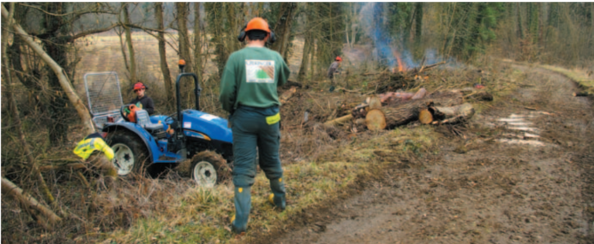
Travaux de traitement de la ripisylve sur le ruisseau de Saulny.
