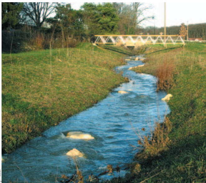
Le secteur 1 de l'Hermance : à gauche, l'Hermance recalibré avant travaux en août 2008 ; à droite, l'élargissement de la section du lit mineur et la plantation en berges, vue en décembre 2009.
