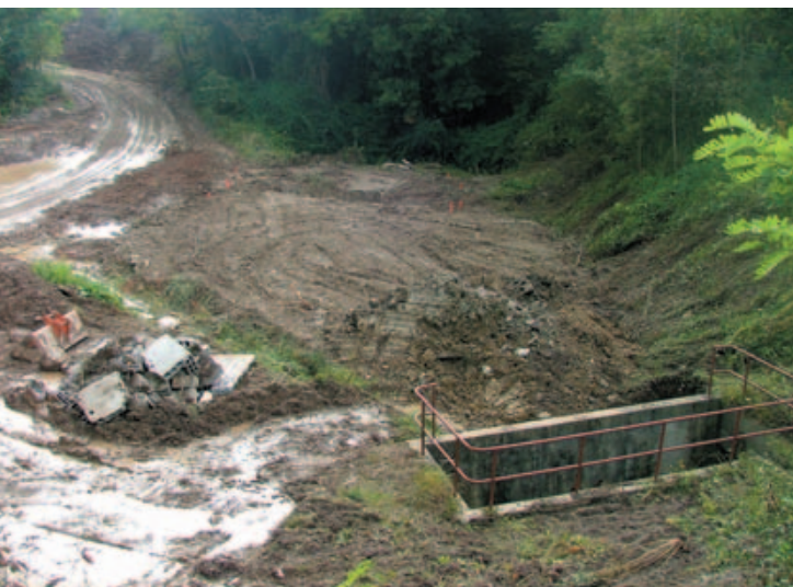
Le Redon aval enterré en 2007, avant travaux.
