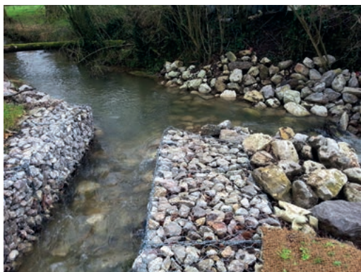
À gauche : ouvrage de M. Lafonte (ROE 26746) avec sa chute résiduelle de 2,06 m sur le bras de Bronne, à Aix-en-Issart. À droite : bras de contournement de l'ouvrage après travaux en juin 2015.
