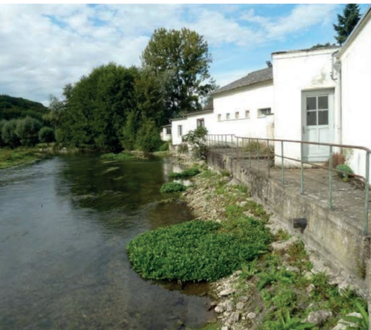
Soubassement de l'usine mis à nu par l'abaissement de la ligne d'eau [2014].
