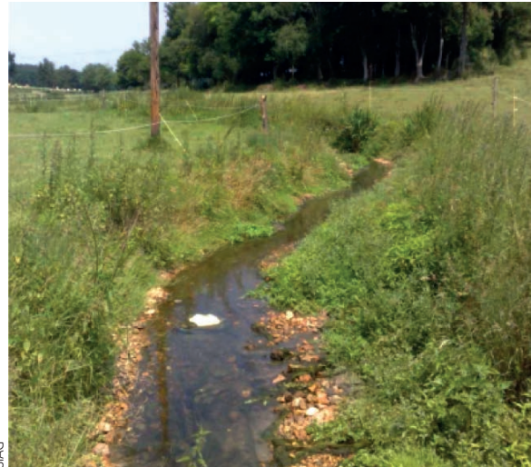
La Luire à Clos Merle après travaux (2010).
