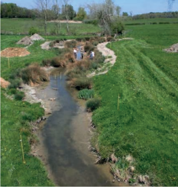
Phase de recharge granulométrique avec recharge du lit mineur et étrépage de la zone humide pour maintenir ses fonctionnalités (2010).
