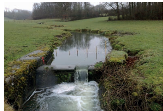
Un des ouvrages problématiques sur la Luire à Clos Merle (2008).
