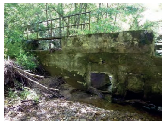
Vue amont de l'ancienne retenue de Cornac en 2011.
