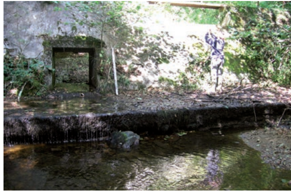
Vue aval de l'ancienne retenue de Cornac en 2011.
