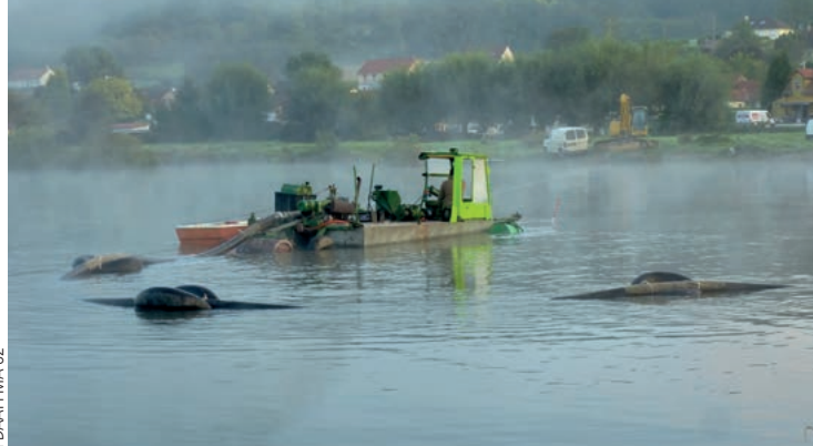
Curage du deuxième étang en septembre 2014.
