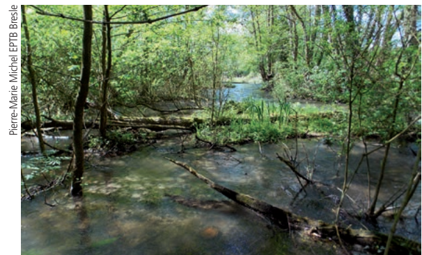
La zone diversifiée après travaux, 2014.
