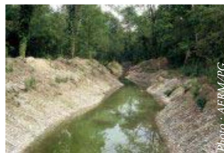
Eiswasser : tracé brut des chenaux après travaux
