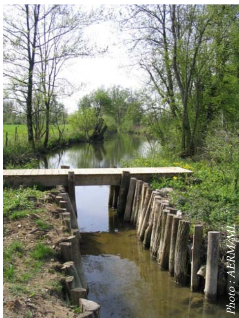
Passerelle et ligne de pieux installées au débouché de la petite noue
