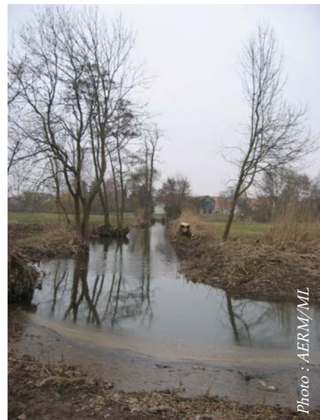
Chenal après travaux
