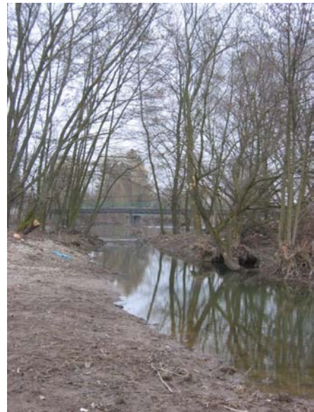
Entrée du bras après travaux
